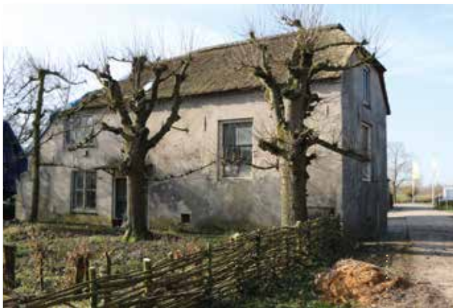
> BOERDERIJ HET BURGJE TE ODIJK (UTR.) MET RECHTS DE STENEN KAMER. FOTO A. VAN BEMMEL 2017
